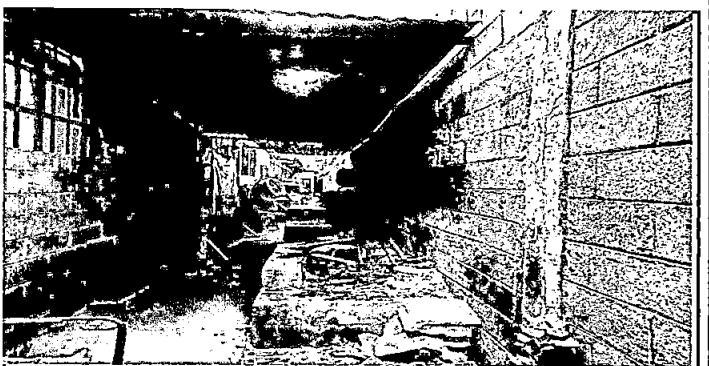
REPARACION DE COCINA
